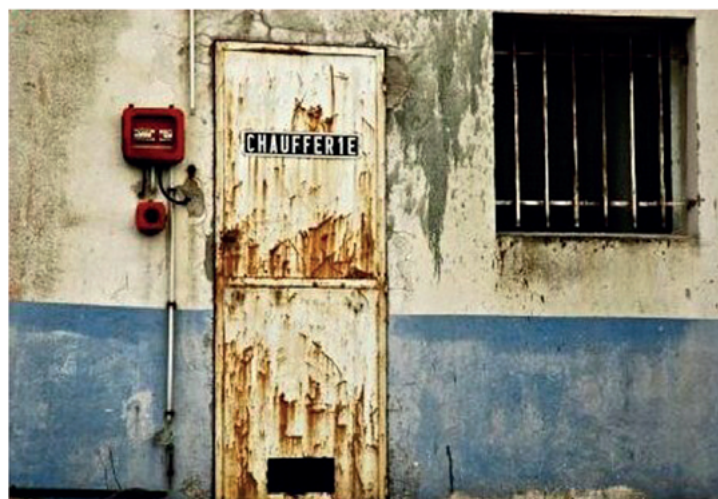
Chaufferie Photographie numérique 30 x 45 cm 280 €
